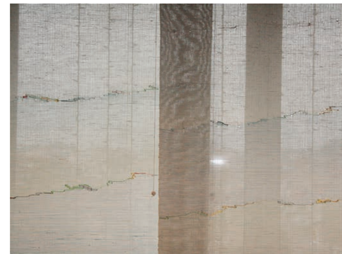
Panneau de Simone Prouvé au centre administratif d'Orly.
