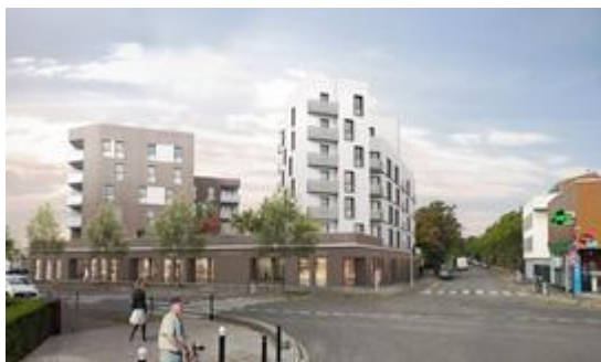
Une maison de santé pluriprofessionnelle ouvrira en 2019 à la Pierre au Prêtre.
